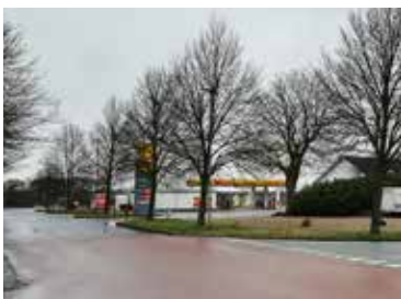
Eksisterende tankanlæg set fra Reinholdts Bakke.
