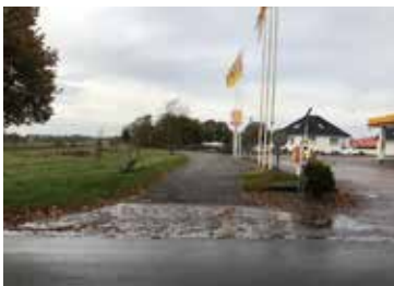
Eksisterende privat fællesvej set fra Reinholdts Bakke.
